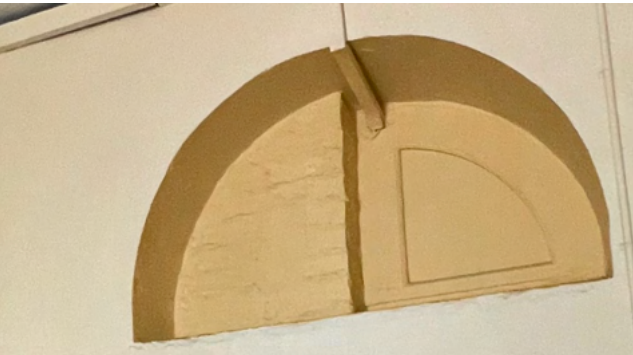
Fig.65. (1) Photographie, l'imposte en demie lune partiellement comblée. Source : Croisée d'archi.
