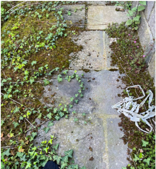
Fig.36. Photographie, dallage en pierre de volvic de la cour A. Source : Croisée d'archi.
